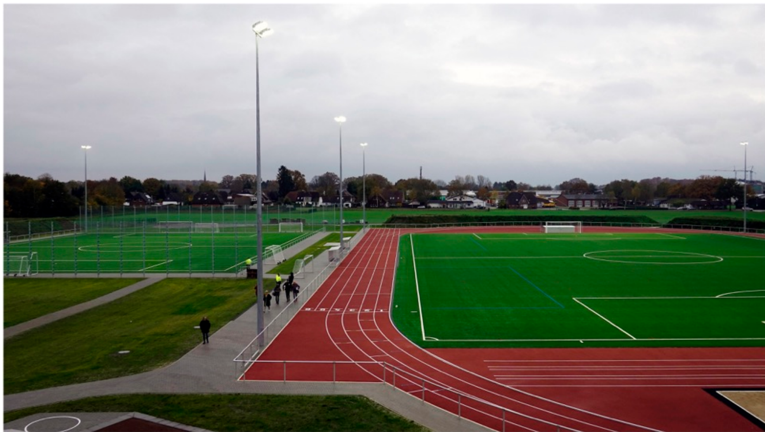
Abb. 01 Neubau Kunstrasen Sportanlagen, Ansicht Richtung Süden
